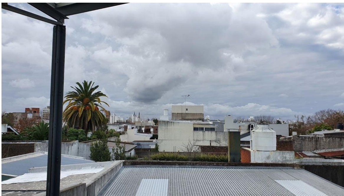
Figura 1A. Vista desde la estructura metálica que conduce al techo de la casa. Pueden observarse las “puntas” de la catedral de La Plata. Figura 1B. Ubicación de la casa, a escasas cuadras del Hospital Italiano de La Plata.
