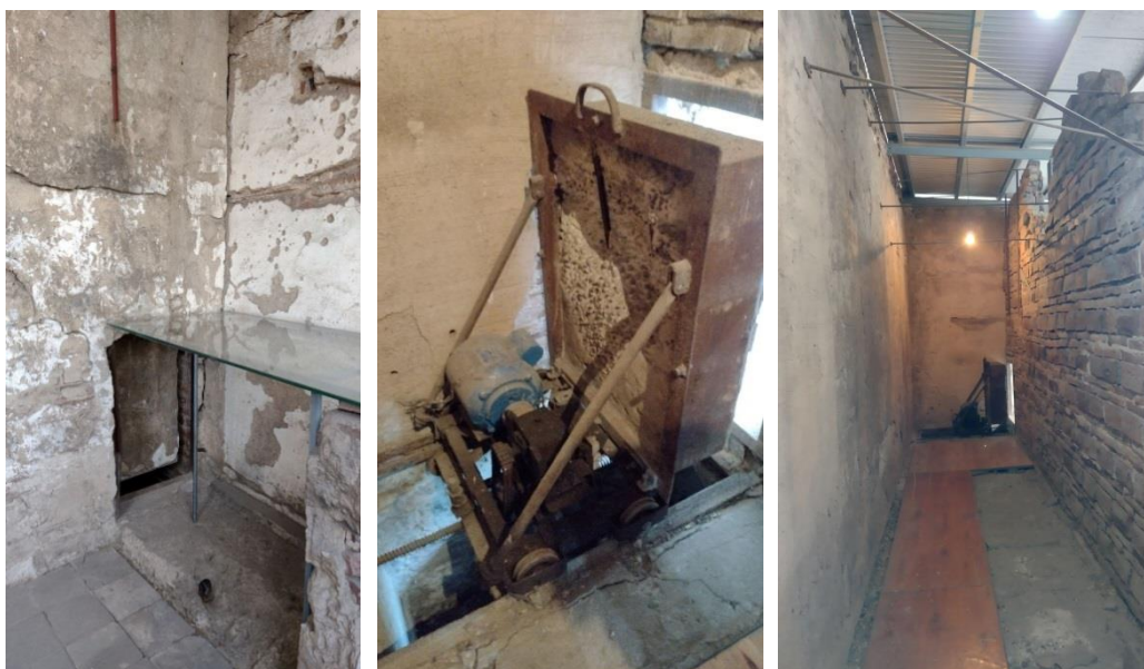
Figura 3. Acceso a la imprenta desde el galpón - Puerta de accionamiento electromecánico con Doble fondo o “embute” 3 donde funcionaba la imprenta.
